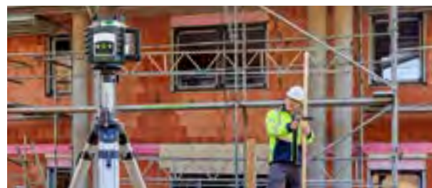
Subito pronto all'uso: Dopo l'accensione e il completo livellamento, la funzione Tilt si attiva automaticamente dopo solo 20 secondi circa
